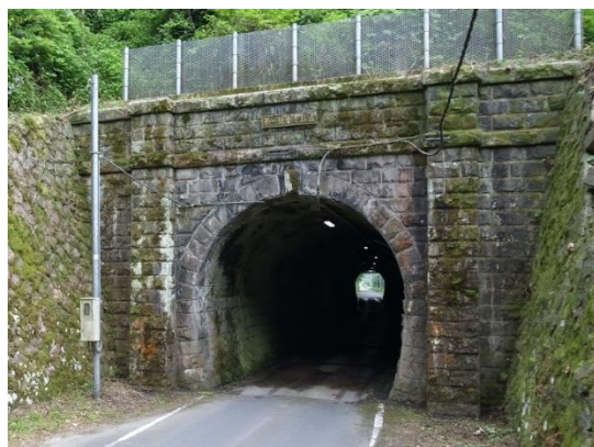
10 第一観音寺トンネル
