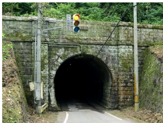
6 葉原トンネル
