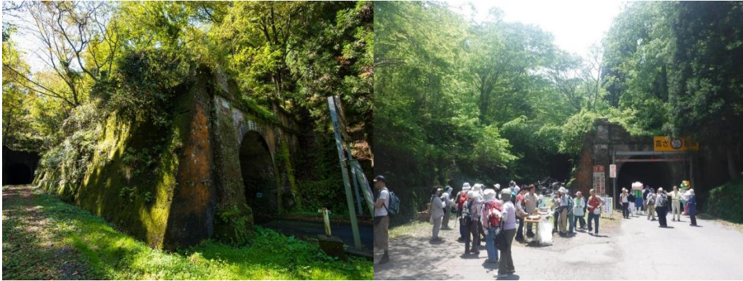
15 山中トンネル
