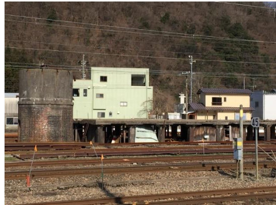
38 今庄駅給水塔・給炭台
