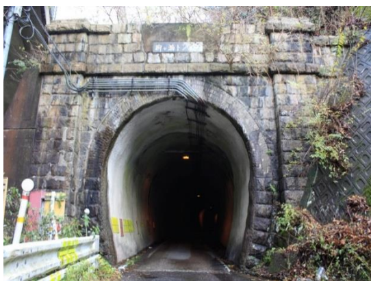
1 柳ヶ瀬トンネル
