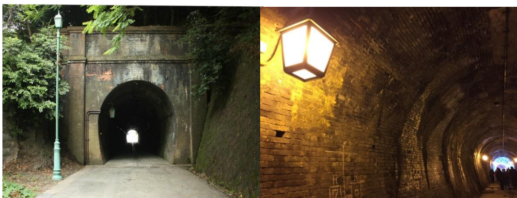
4 檜曲トンネル
